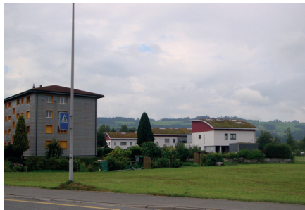
Abb. 36 Isolierte Neubauten Luzernerstrasse
