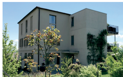
Kirchbühl: Kleines Mehrfamilienhaus mit grünen Freiflächen; klare Adressierung an der Strasse (Bild: vdw)
