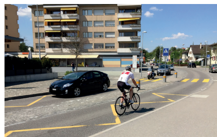
Fahrbahnhaltestelle Birmensdorf Zentrum: ÖV-Priorisierung, Anpassung und Verlangsamung des Verkehrsflusses, einfachere kleinräumliche Einbettung im Strassenraum, bessere Querbarkeit der Strasse (Bild: vdw)
