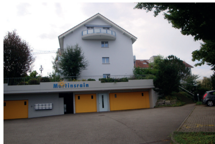
Abb. 22 Block mit EG-Parkierung an der Gotthardstrasse
