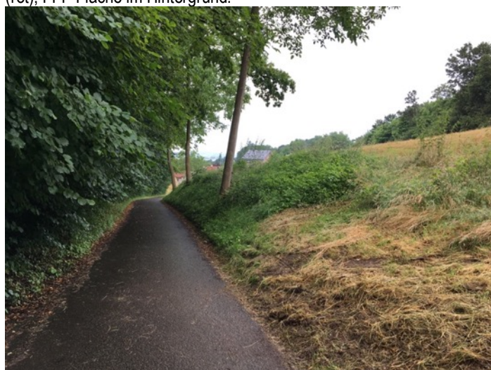
Abb. 7: Böschung entlang Zufahrtsstrasse auf Parzelle Nr. 1043; Blickrichtung Westen. Hangneigung > 25 %.
