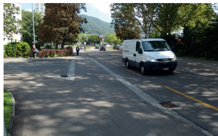
Wettingen, Zwyszigstrasse: Minimale Verkehrsflächen dank Kernfahrbahn; Priorisierung Fussgänger dank Trottoirüberfahrt (Bild: vdw)
