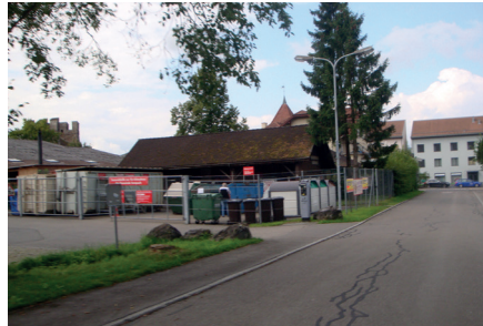
Abb. 14 Werkhof östlich der Altstadt
